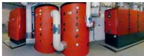
Technique de pointe pour le centre des véhicules utilitaires de Mercedes-Benz à Francfort : système de chauffage avec centrale de cogénération PowerBloc, chaudière à gaz à condensation UltraGas®, accumulateur tampon d'énergie et composants systèmes complémentaires.
