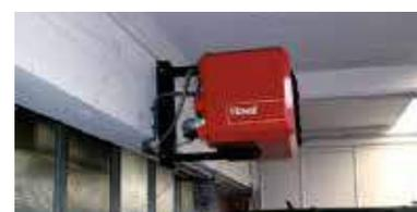
Les TopVent® GV sont destinés à être installés sous la toiture ou sur un mur.
